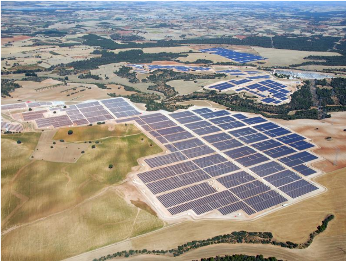
největší elektrárna na světě – Olmedilla (Španělsko) – 60MW
