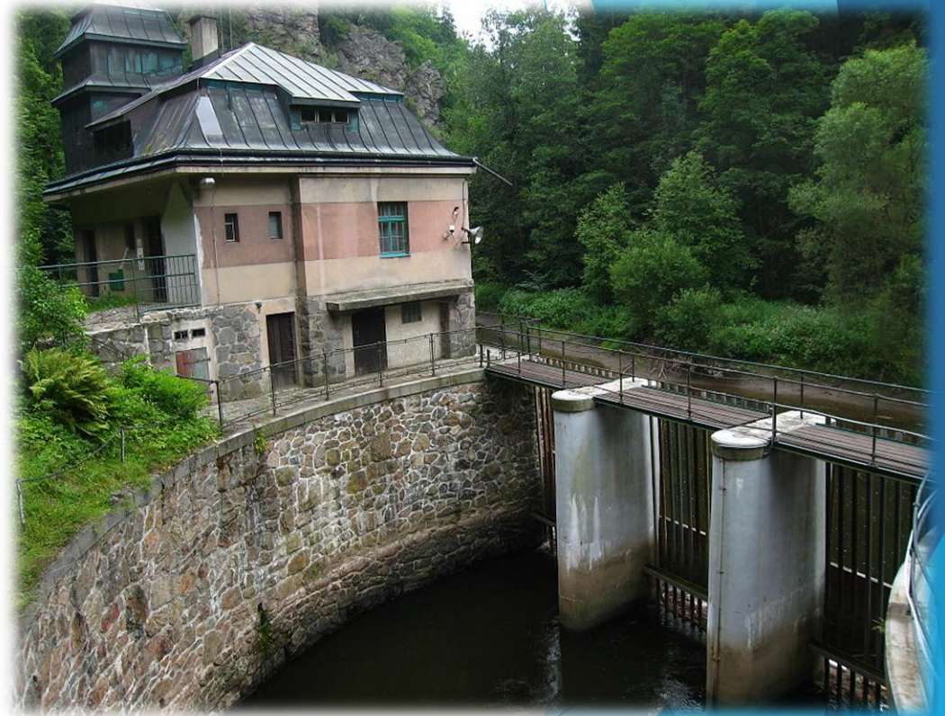
Malá vodní elektrárna
