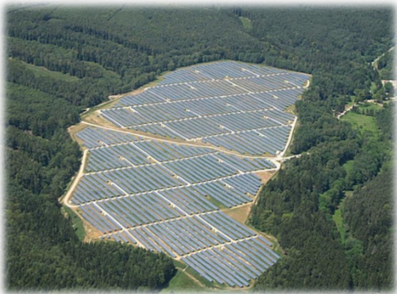
Solární elektrárna Ralsko Ra 1
