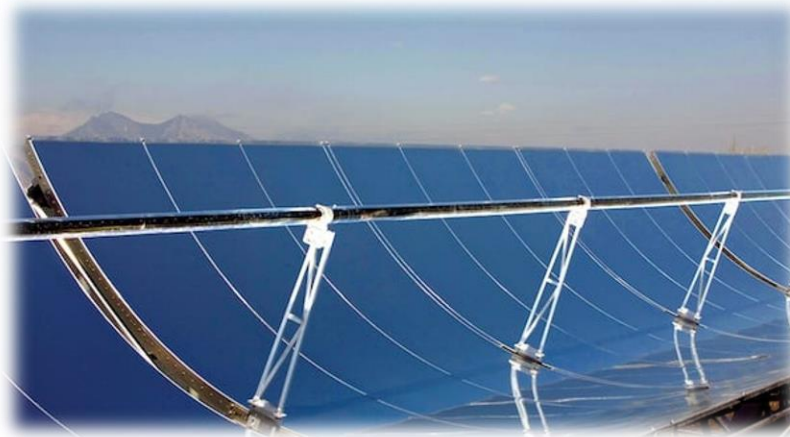
Solární termální elektrárna
